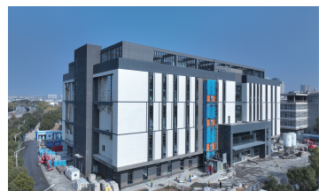
实验动物中心大楼完成主体验收
